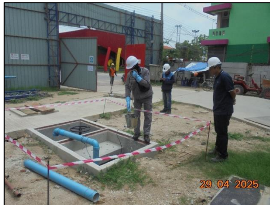
รูปที่ 4.10 การเก็บตัวอย่างคุณภาพน้ำทิ้ง บริเวณบ่อพักสุดท้ายก่อนระบายออกจากโครงการ
